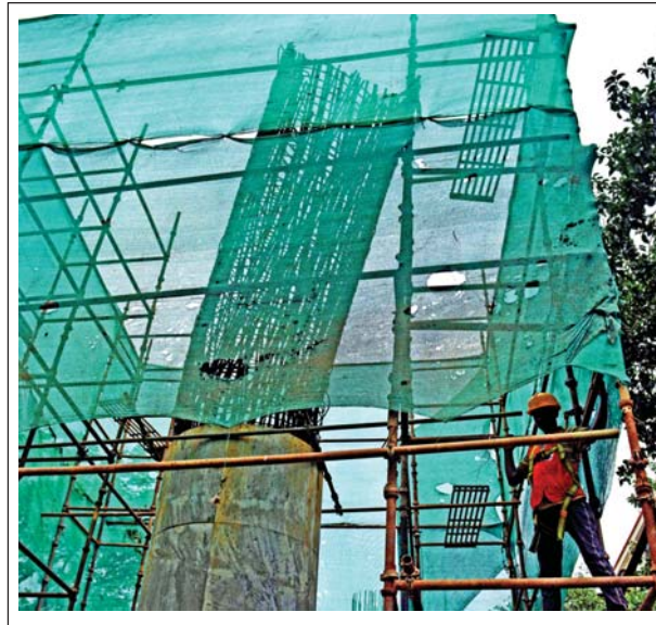
દુર્ઘટના ટળી... ડી. એન. નગરમાં દહિસર-ડી. એન. નગર મેટ્રો-ટૂબી કન્ટ્રોલરૂમ સાઈટ પર લોખંડના સળિયાનો પીલર નીચે નમી ગયો હતો. જોકે, બેરિકેડિંગ કરવામાં આવ્યું હોવાથી કોઈ દુર્ઘટના સર્જાઈ નહોતી. (જયપ્રકાશ કેળકર)
